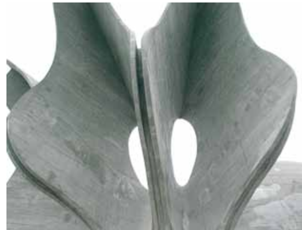
Спомен-подручје Јасеновац, детаљ бетонске конструкције
